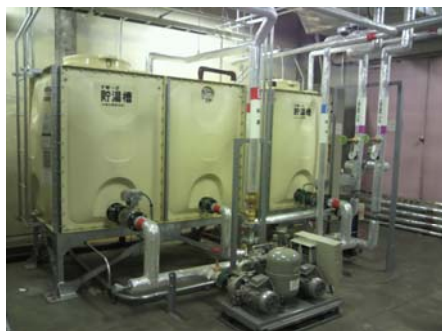
▲太陽熱+空気熱 貯湯槽
