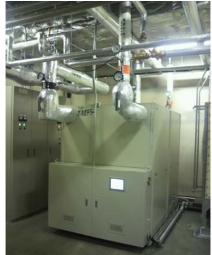
▲地中熱ヒートポンプ チラー
